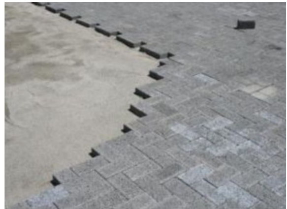
FIGURA 8: Pavimentação com encaixes
