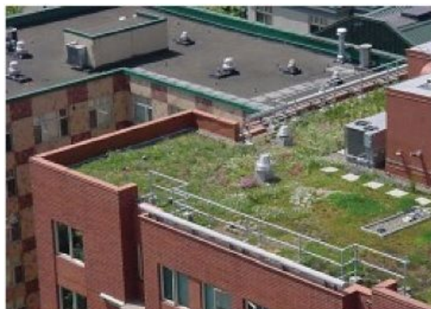
FIGURA 9: Cobertura com vegetação.
