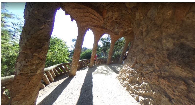
Figura 15 – Visão inferior à um dos viadutos do Parc Guell.
