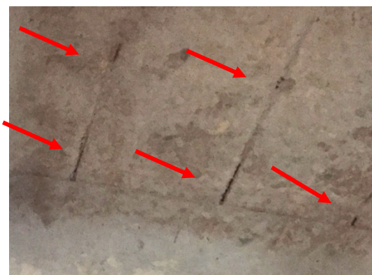
Figura 12: Vistoria de Entrega de Obra. Fonte: Arquivo pessoal da autora.
