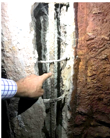
Figura 11: Vistoria de Entrega de Obra. Fonte: Arquivo pessoal da autora
