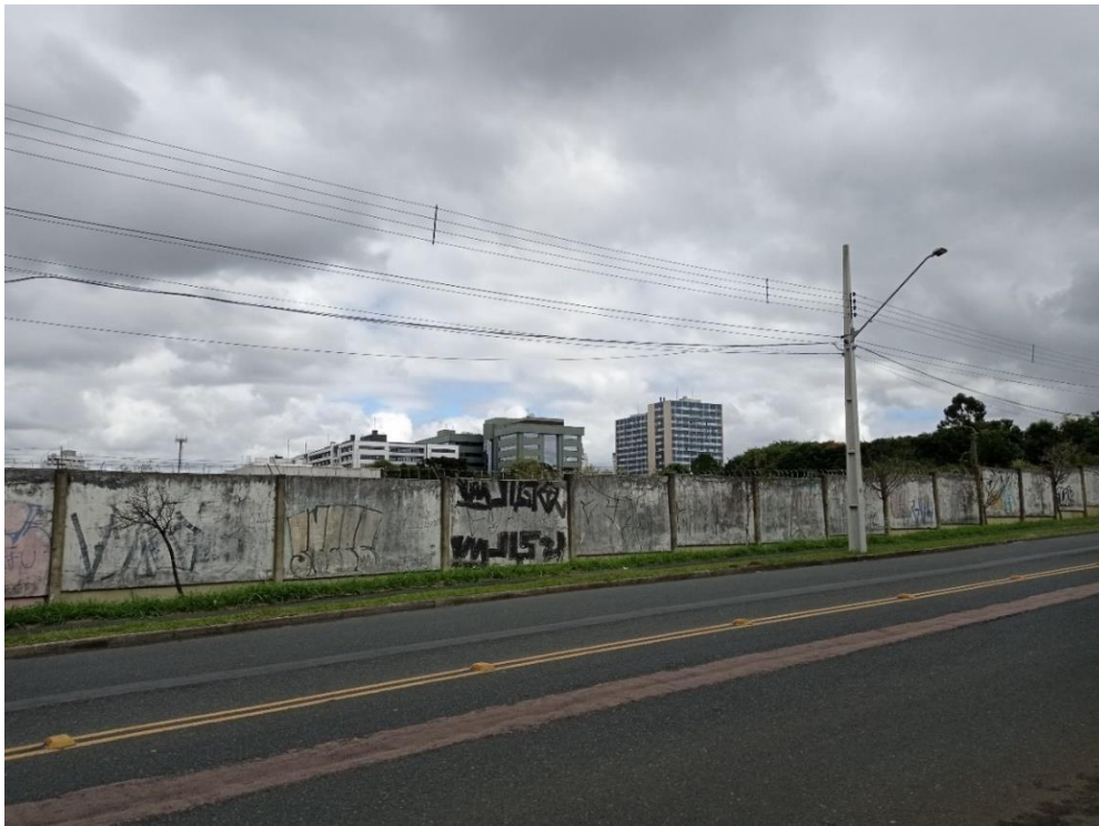
Figura 14 - Parte da quadra fechada por muro
