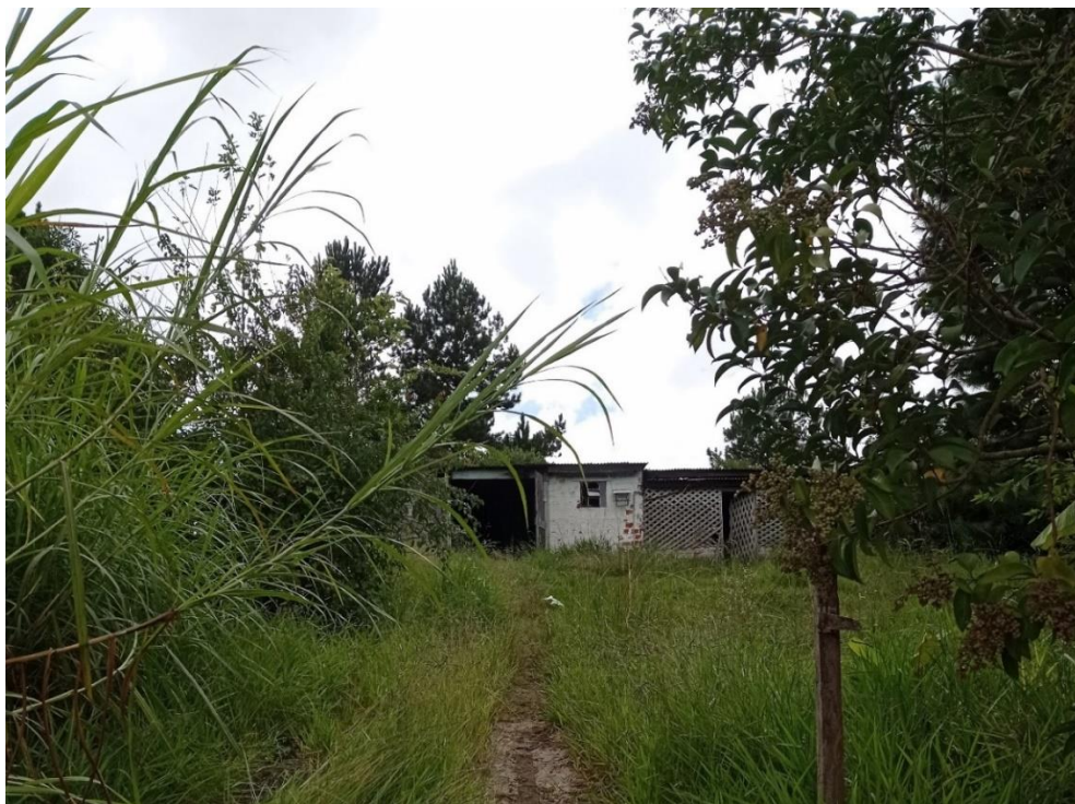
Figura 16 - Edificação de alvenaria e madeira na ocupação de intervenção
