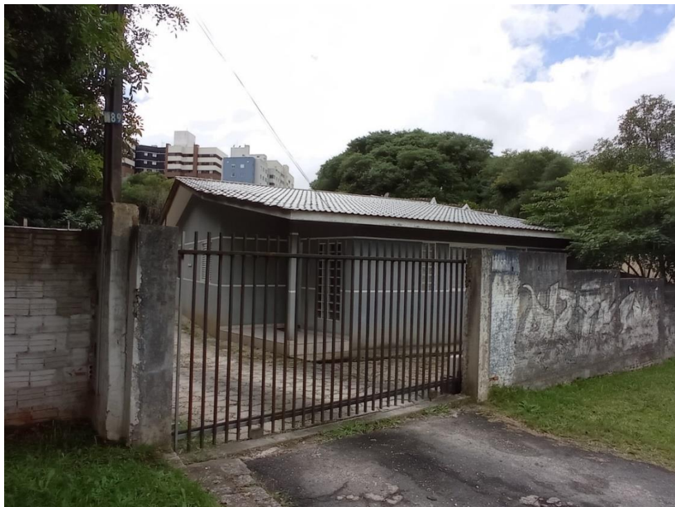
Figura 15 – Edificação de alvenaria na ocupação de intervenção
