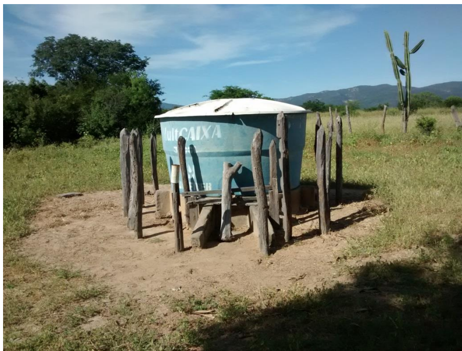
Figura 5.16 - Solução alternativa coletiva em Barreiro Amarelo Caixa d'água onde a água fica armazenada e é coletada
