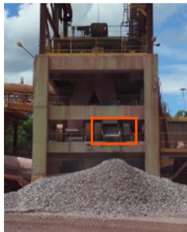
Figura 16: Retirada da CC da Britagem
