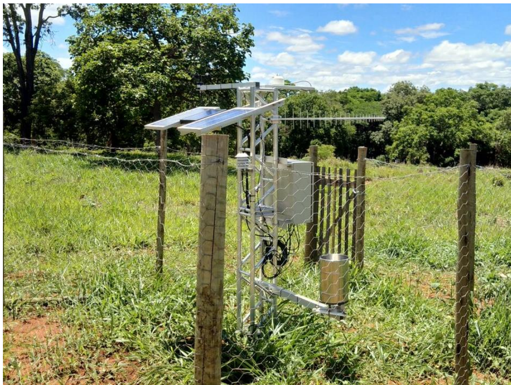
Figura 30 - Estação meteorológica instalada na UFV Stella Maris. Fonte: Autor
