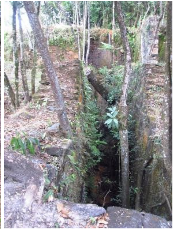
Figura 35 – Estrutura em alvenaria de pedras que sustentava as rodas d'água da antiga mina (IV)
