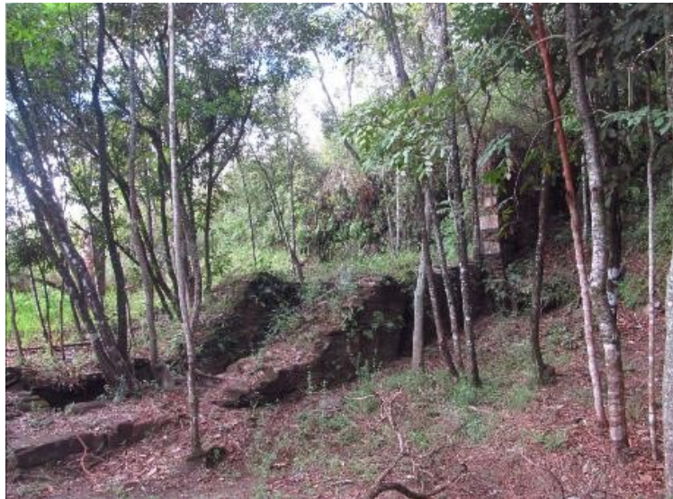
Figura 32 – Estrutura em alvenaria de pedras que sustentava as rodas d'água da antiga mina (I)
