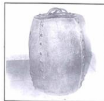
Tambor em chapa cravada que era utilizado para transportar minério do fundo da mina para o exterior para ser apurado o ouro
