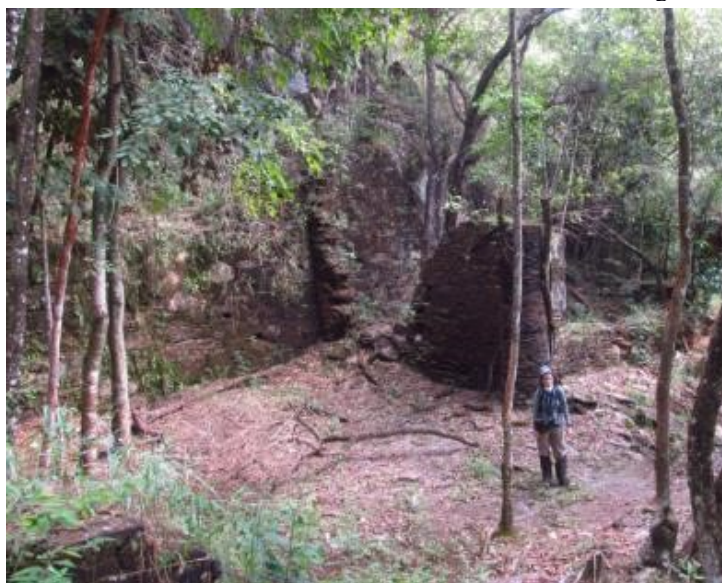
Figura 39 – Estrutura remanescente de sistema hidráulico da antiga mina (I)
