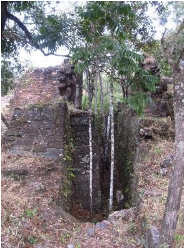
Figura 34 – Estrutura em alvenaria de pedras que sustentava as rodas d'água da antiga mina (III)
