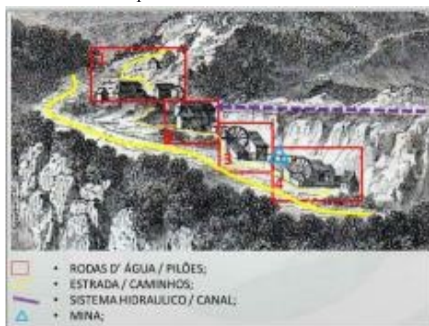
Figura 23 – Estruturas da planta de beneficiamento da mina de Cata Branca
