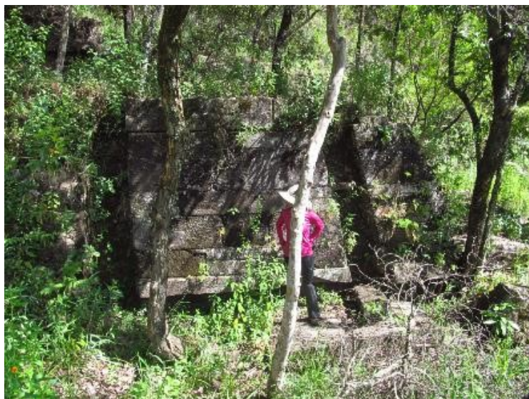
Figura 38 – Encaixes para suporte das rodas d'água nas estruturas em alvenarias de pedra
