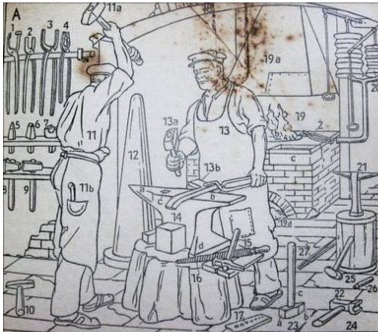
FIG. 13 - Esquema de oficina e forja do início do século XX. Quase não há diferenças entre esse esquema e o de meados do século XIX. Estas oficinas foram as precursoras das empresas metal-mecânicas (que utilizavam máquinas em substituição ao trabalho puramente braçal) e eram importantes consumidoras de ferro até o surgimento de empresas maiores. (Imagem: KLEIN, H. & KLEIN, M. Ridpath. The English Duden . Leipzig: Bibliographisches Institut ag., 1937)
