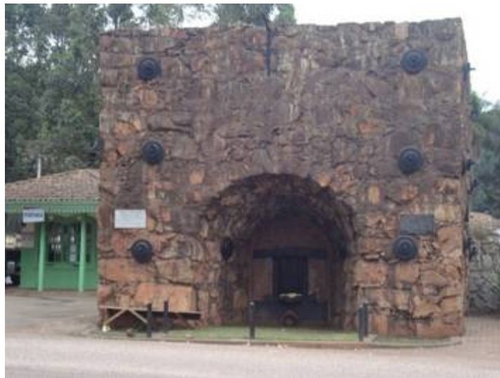
FIG. 16 - Parte do alto forno da Usina Esperança reconstruído à margem da estrada de acesso a Itabirito/MG pela Empresa Queiróz Júnior na década de 1960. (Acervo do autor).
