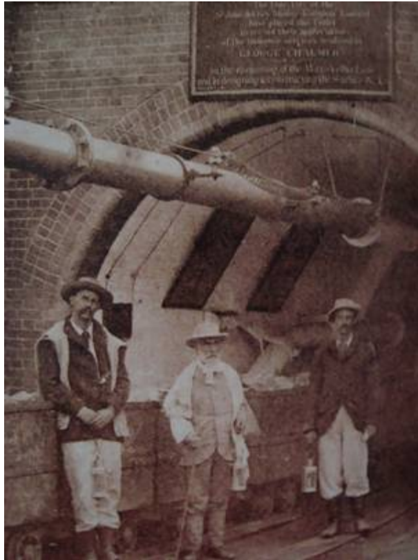
FIG. 8 - George Chalmers, Frederic Tendron e um funcionário em frente à entrada da mina de Morro Velho por volta do final do século XIX. (Acervo do Centro de Memória da Mina de Morro Velho).
