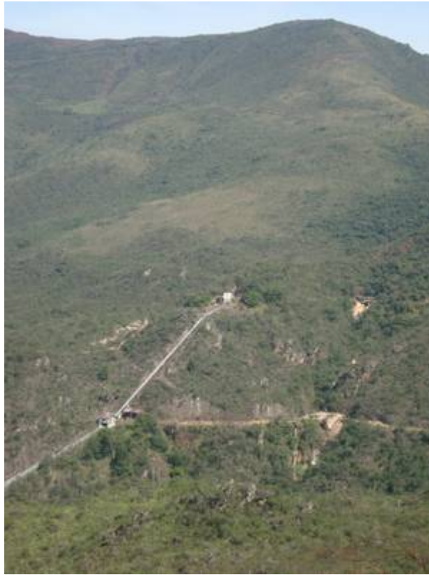
FIG. 10 - Discretas estruturas na encosta da montanha, as duas pequenas casas fazem parte das usinas do sistema do Rio do Peixe, (Usinas C e D - a casa da usina mais baixa, dentro do vale, não aparece na foto) e operam até hoje, integradas ao sistema CEMIG. (Foto tirada da estrada entre a BR-040 e Rio Acima, conhecida como 'intermunicipal'. - Acervo do autor)
