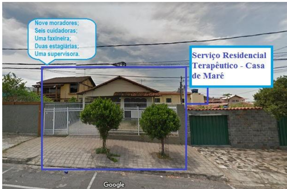
Figura 8: Fachada SRT casa de Maré
