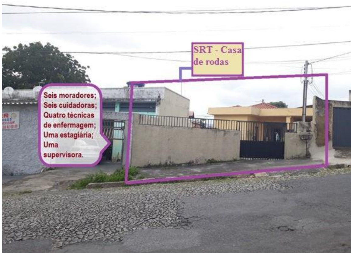
Figura 12: Fachada do SRT Casa de Rodas
