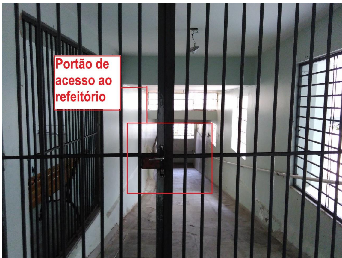
Figura 25: Portão do refeitório do Hospital Transitório
