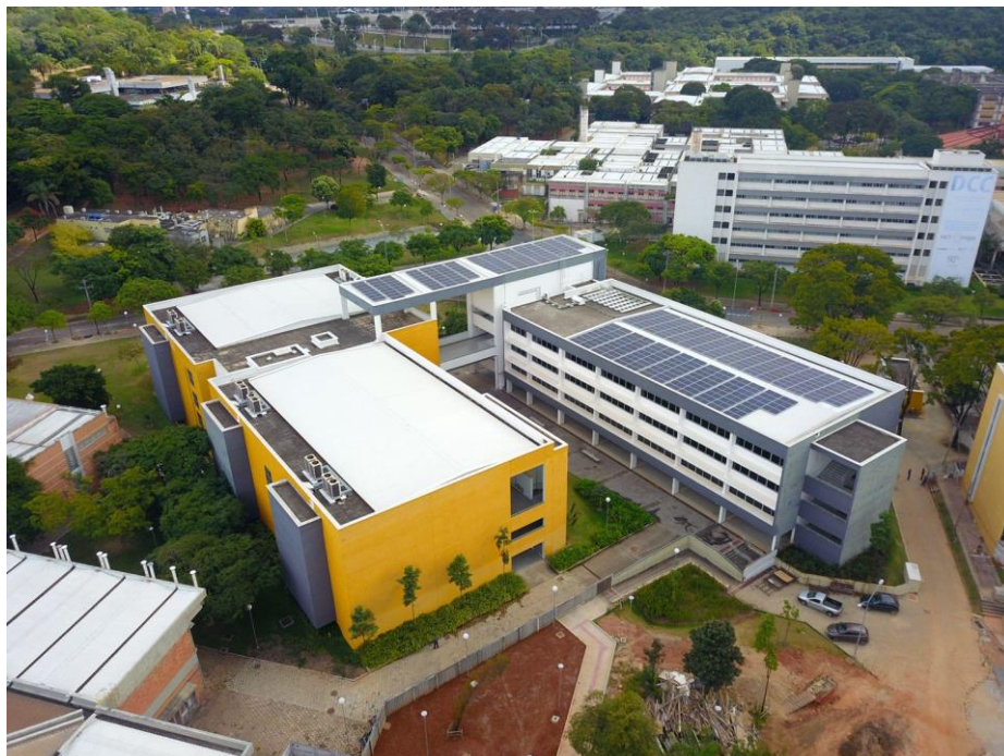
Figura 38. Edifício do Centro de Atividades Didáticas de Ciências Exatas 3 da UFMG
