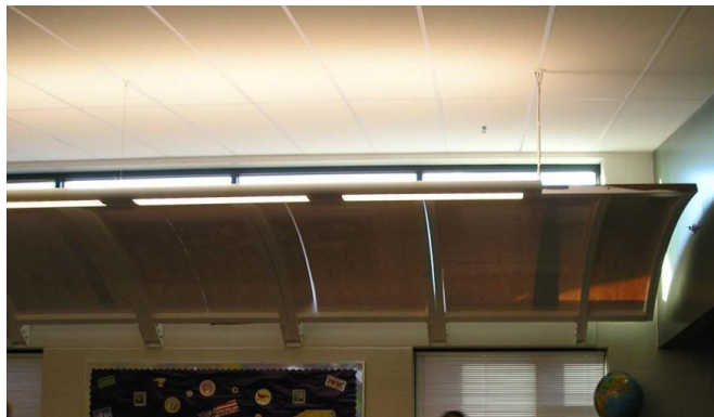
Figura 20. Prateleira de luz coberta com papel em interior de sala de aula
