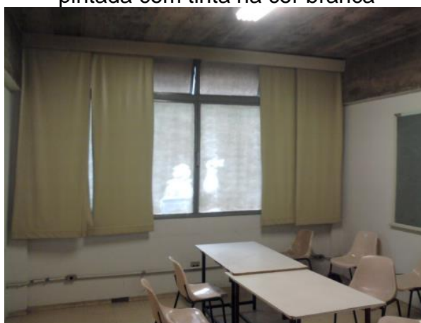
Figura 18: sala de aula com janelas na fachada oeste, pintada com tinta na cor branca
