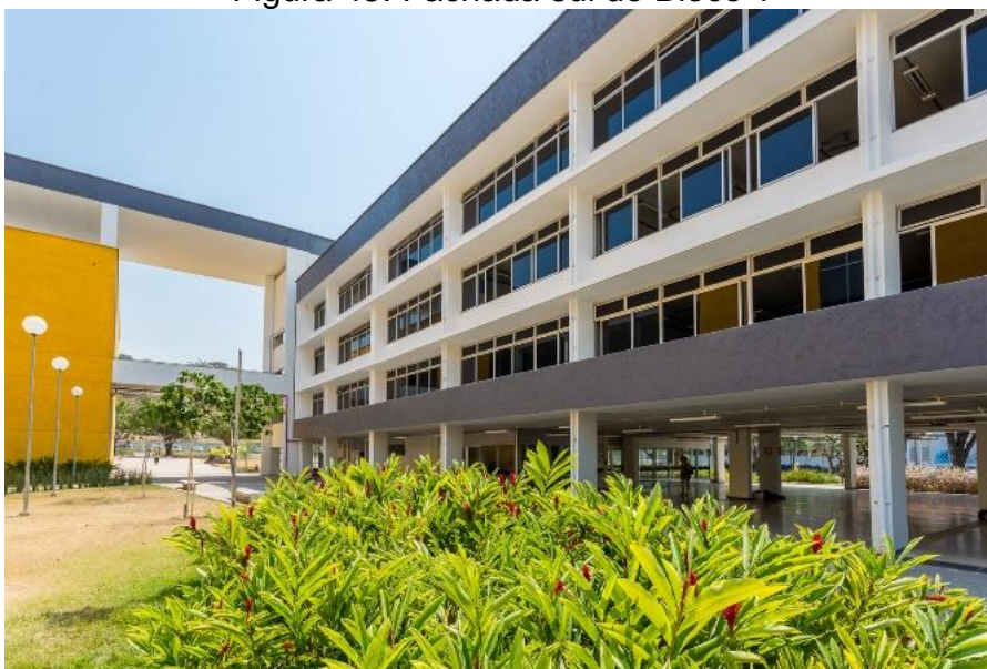
Figura 45. Fachada sul do Bloco 1
