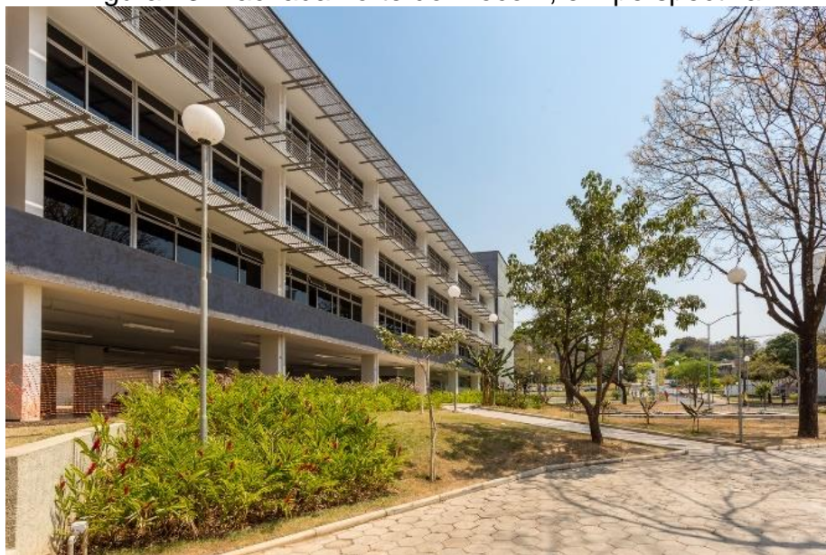
Figura 43. Fachada norte do Bloco 1, em perspectiva
