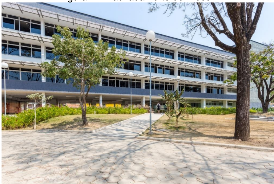
Figura 44. Fachada norte do Bloco 1
