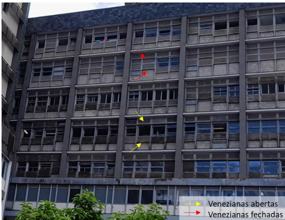
Figura 16 - Fachada da Ala Leste, com indicação das venezianas
