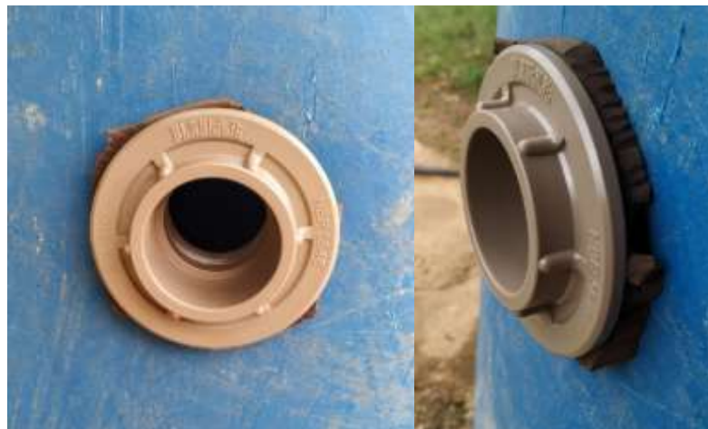
Figura 32 – Detalhe do tambor plástico (frente e perfil), com o furo lateral, encaixado com flange e borracha.
