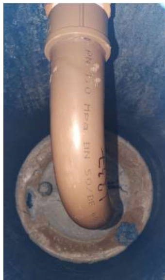
Figura 34 –Curva e adaptador encaixados no flange pelo lado interno do tambor plástico.
