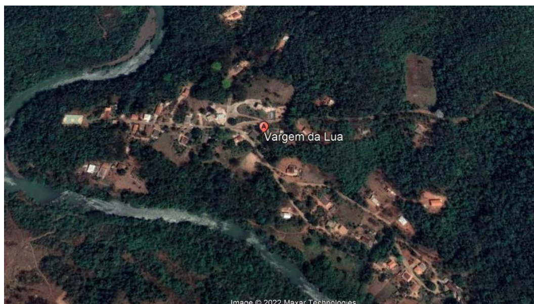
Figura 106 - Perspectiva geral do arruamento da comunidade de Vargem da Lua - São Gonçalo do Rio Abaixo/MG
