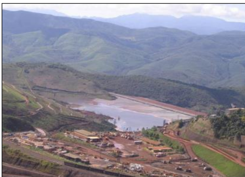
Figura 3.30 Foto aérea da barragem Sul Superior, Mina Gongo Soco. (VALE, 2008).
