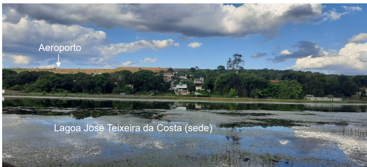
Figura 22 – Vista do talude de implantação e aeroporto.
