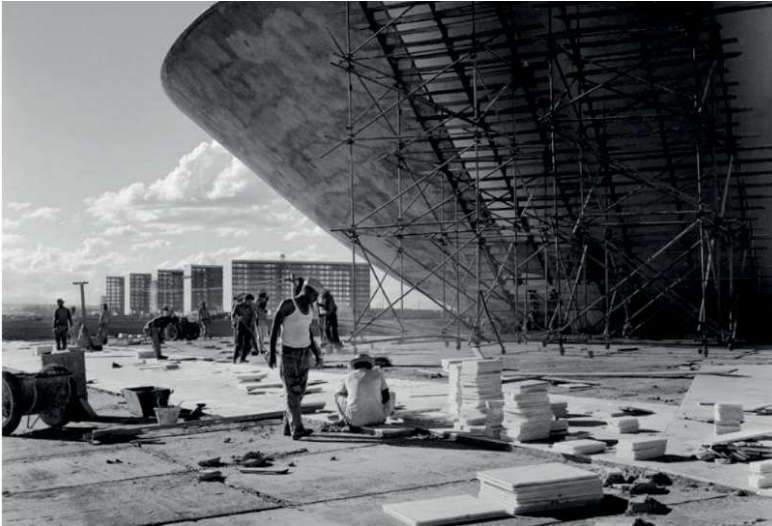
Figura 1. Trabalhadores na construção da Câmara dos Deputados do Congresso Nacional
