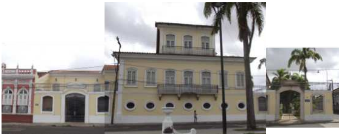
Figura 1 – Montagem Fachada Oeste – Rua dos Remédios
