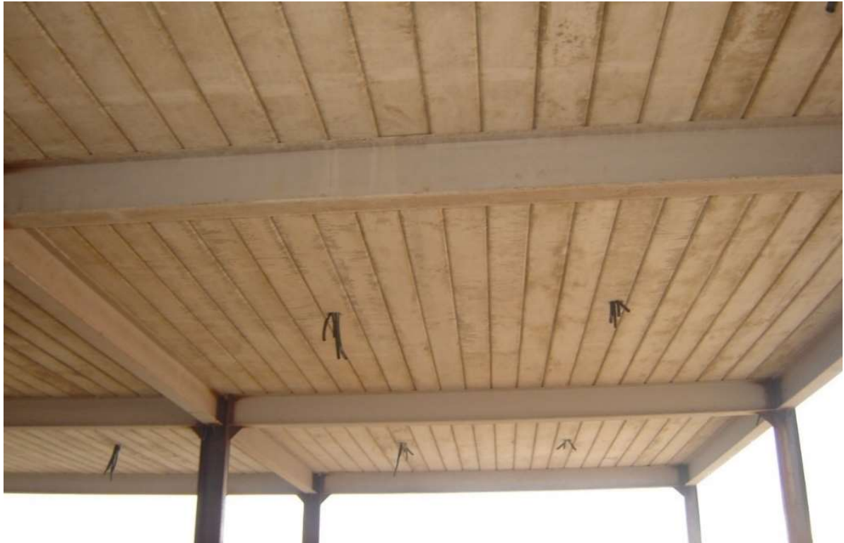
Figura 14 – Laje de Painéis Treliçados
