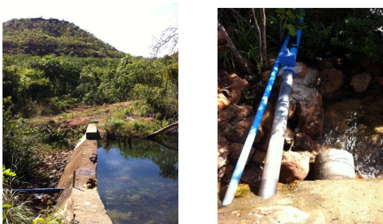
Figura 1. Barramento construído para captação de água na comunidade Barroirão de Cima, Barreiras-BA.
