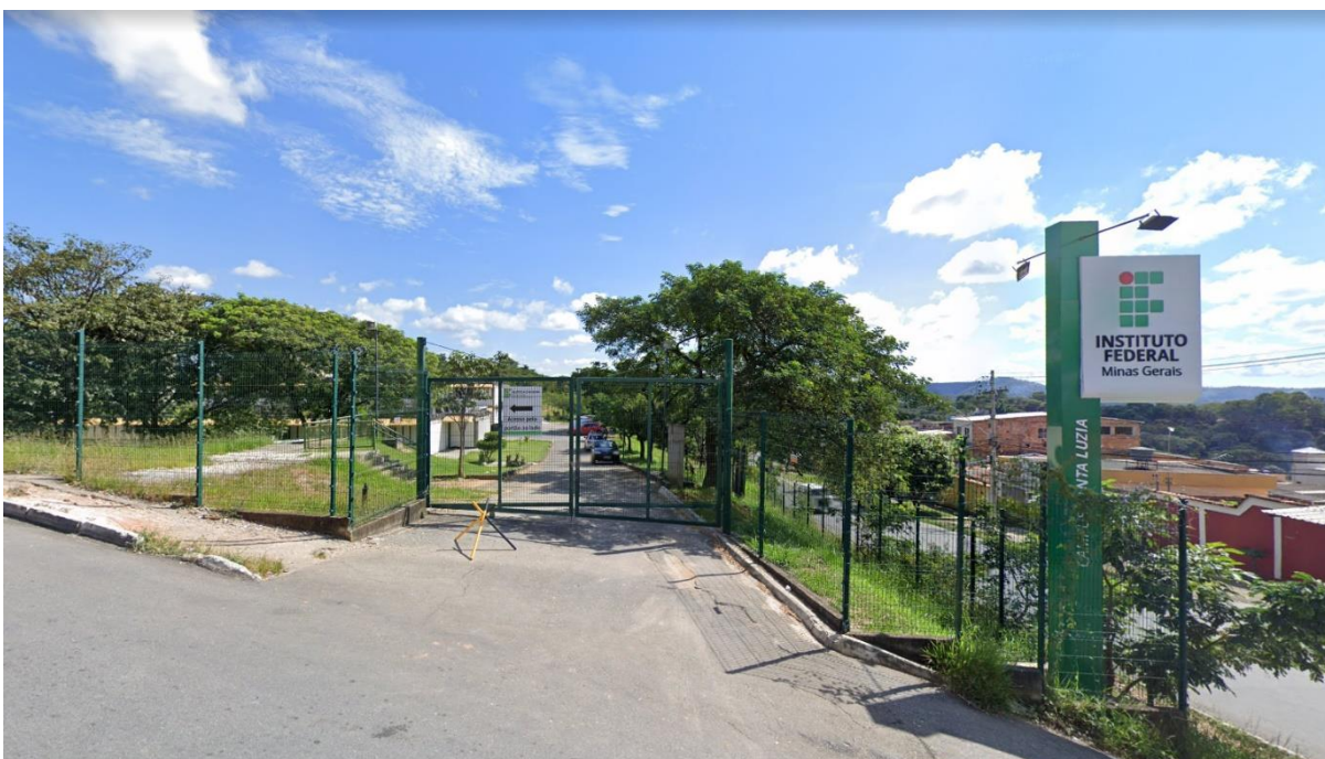
Figura 05 – Portaria entrada de veículos do campus
