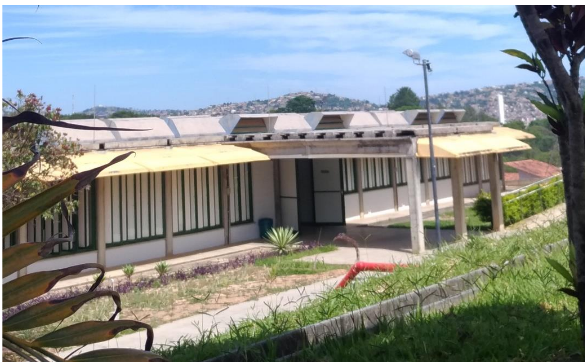
Figura 07 – Fachada do Bloco C
