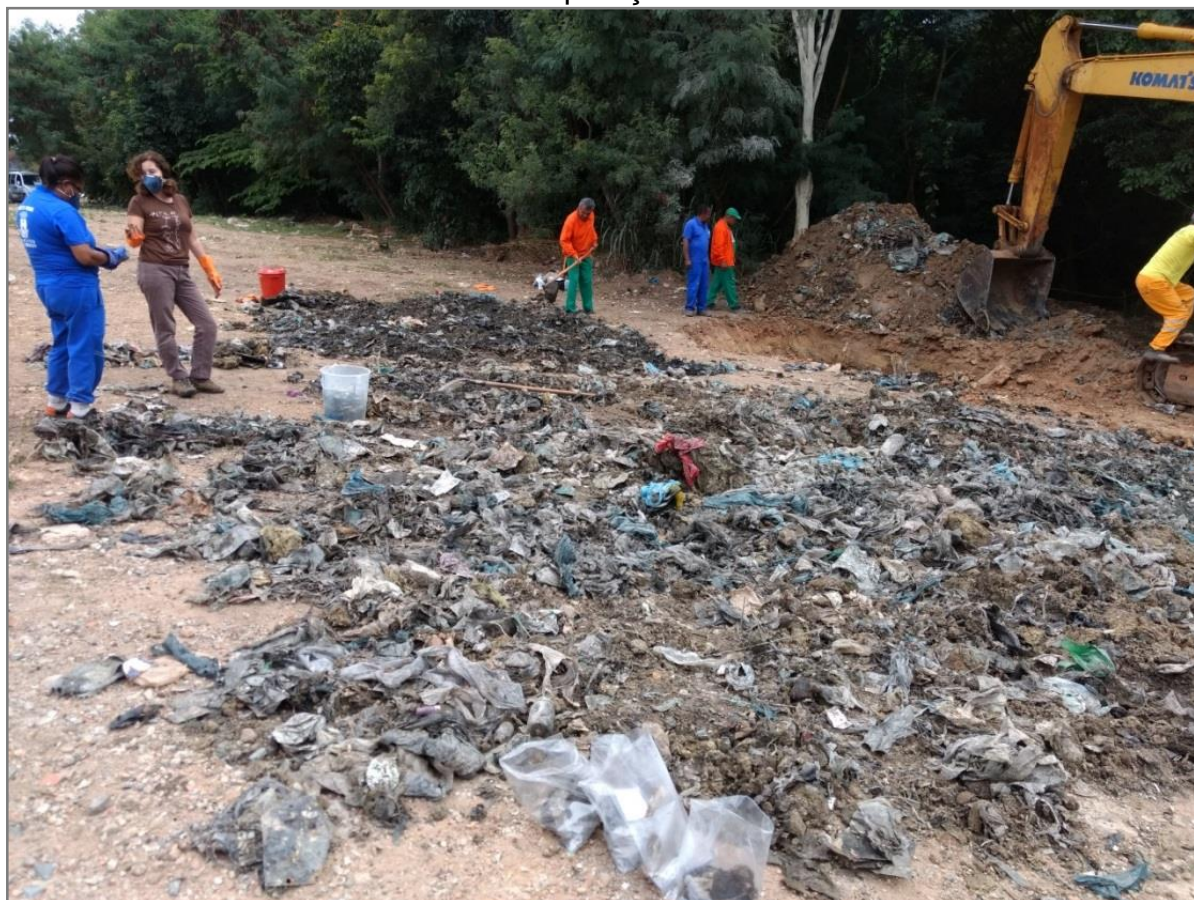
Figura 13 - Primeira escavação (A1) – Espalhamento do material para primeira separação
