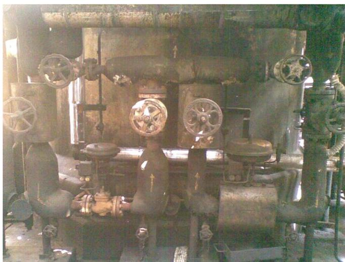
**Figura 02 - Manifold com válvulas controladoras e bloqueios entrada e saída**
