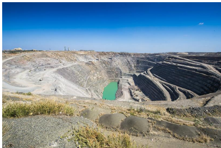
Figura 1: Exemplo de operação em lavra a céu aberto.
