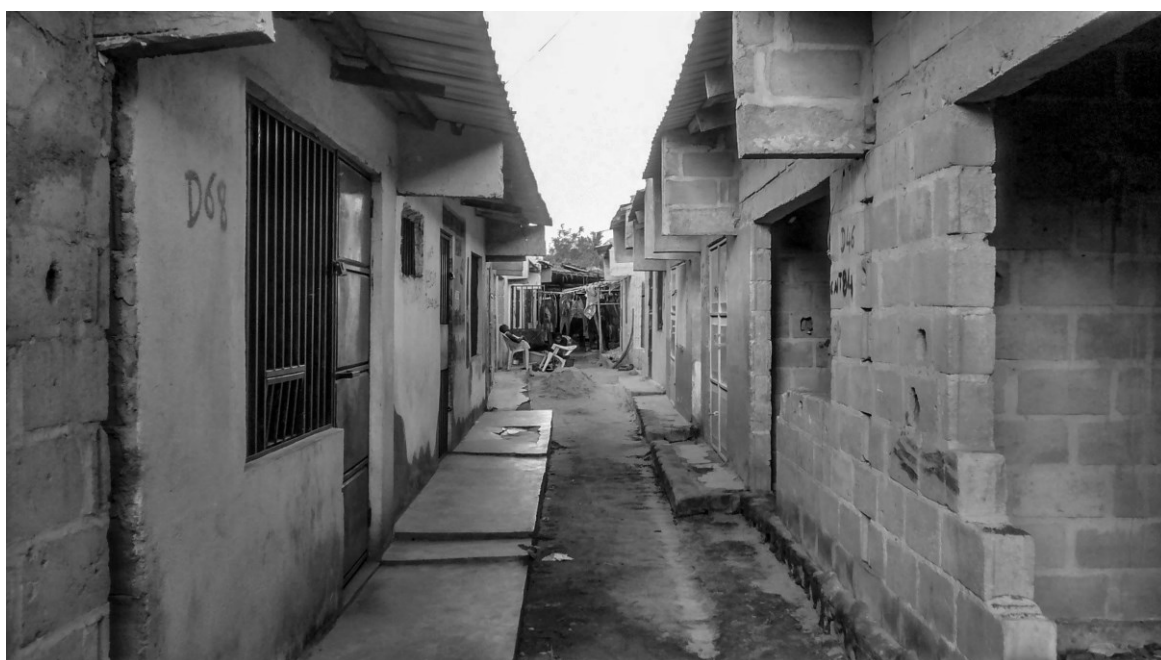
Fotografia 33: Expansão do Mercado Matadouro - construção do novo espaço para realocação do Mercado dos Bombeiros
