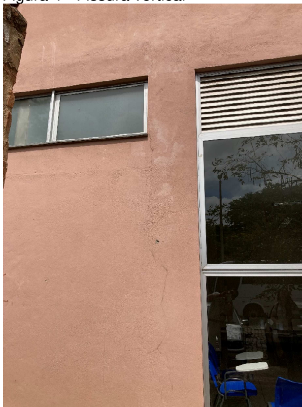
Figura 4 - Fissura vertical
