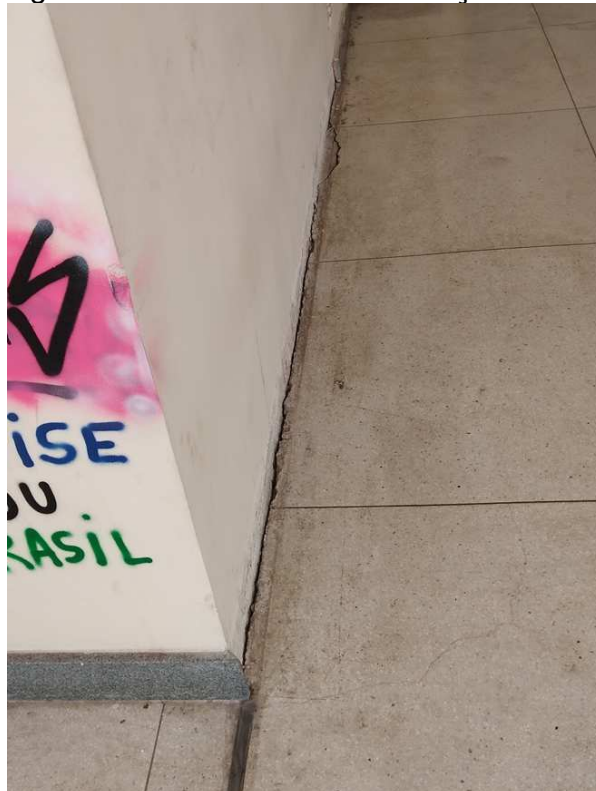
Figura 20 - Junta de movimentação estrutural
