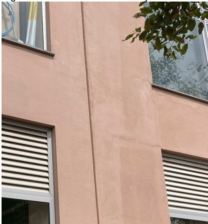
Figura 3 - Juntas de movimentação da estrutura
