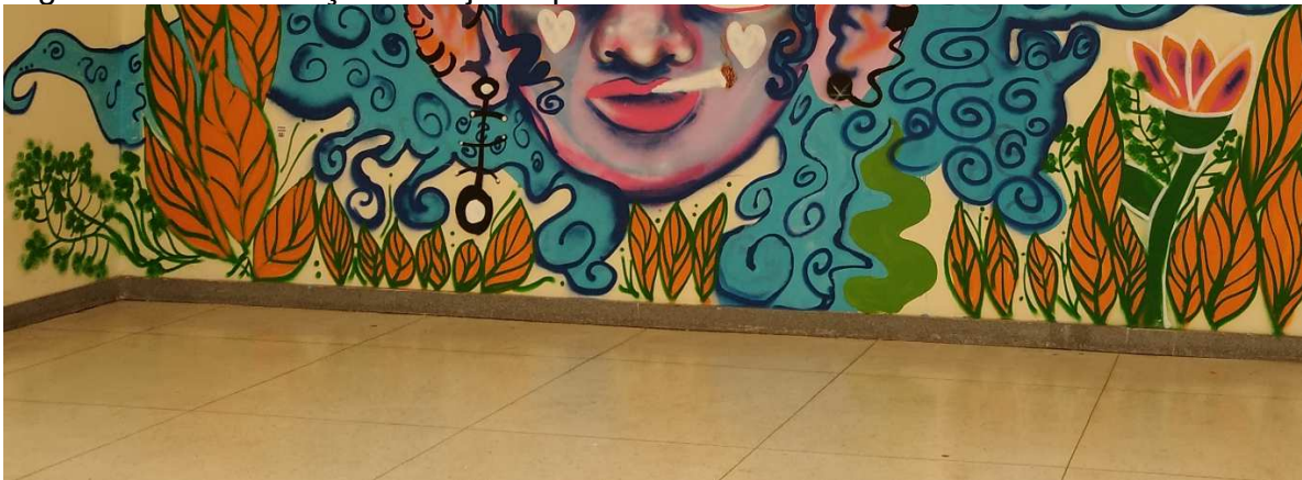
Figura 19 - Deformação na laje de piso
