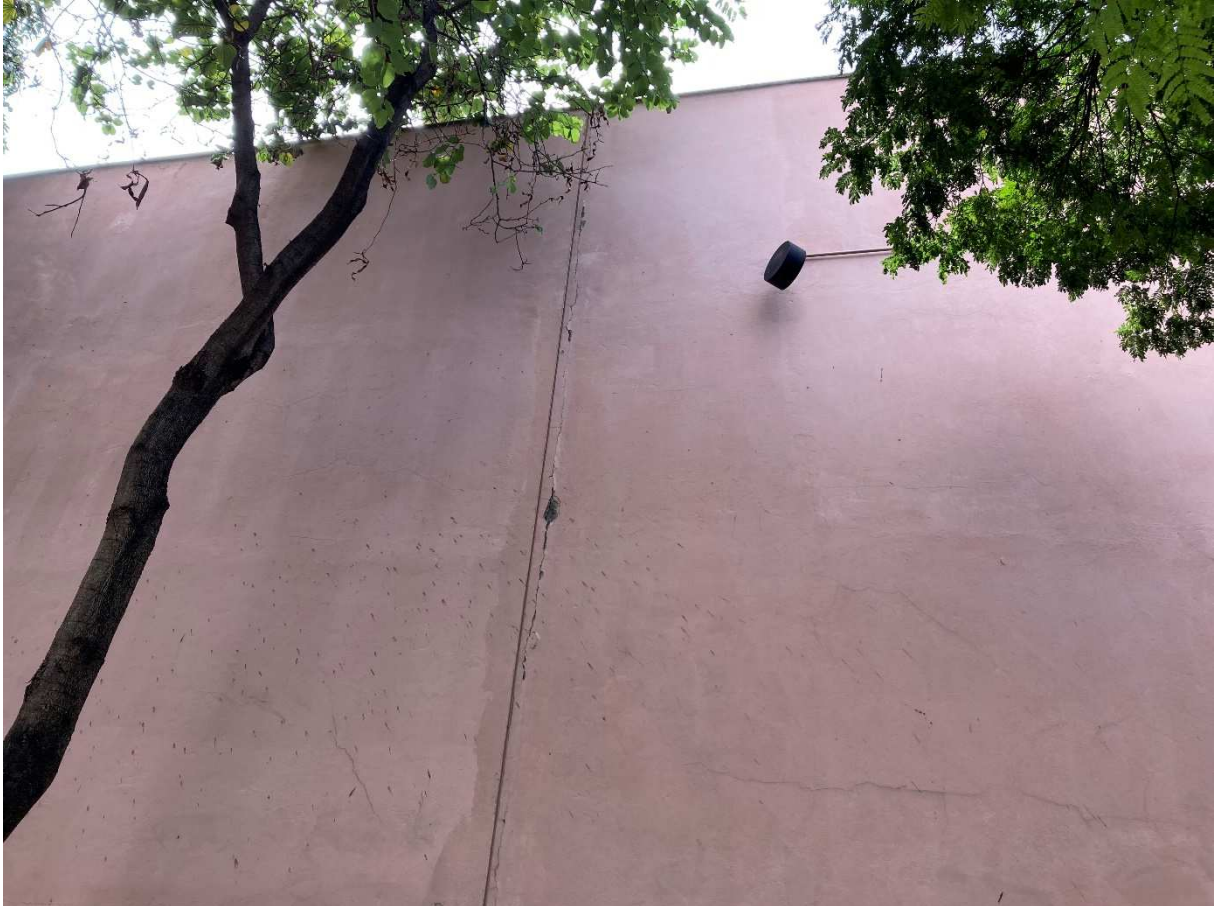
Figura 12 - Junta de movimentação estrutural
