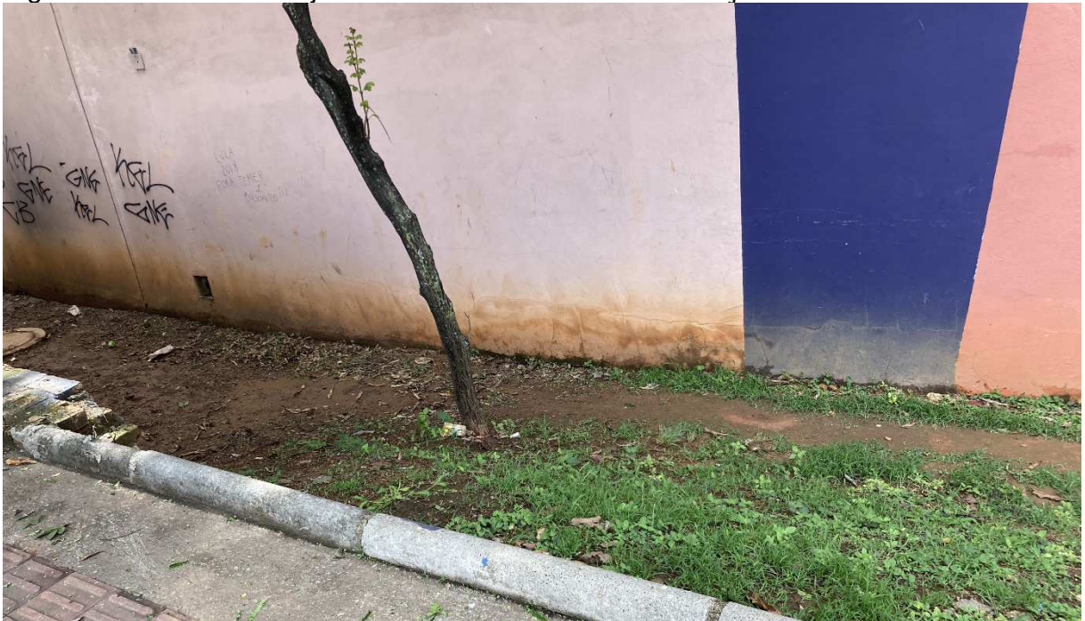
Figura 13 - Encontro de jardim com a estrutura da edificação
