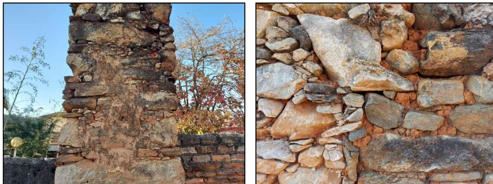
Figura 14. Colunas compostas de emparelhamentos de pedras irregulares e argamassa. Fotografia: Caroline Ferreira, 2021.
