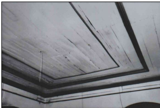
Figura 39. Fotografia do forro dos salões em estilo "saia e camisa" ou "saia e blusa", década de 1990. Fonte: Foto Araújo.
