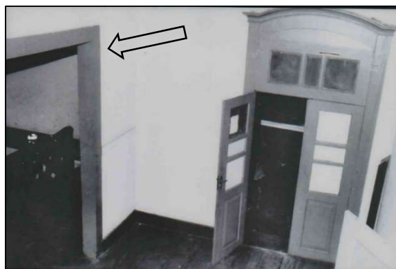
Figura 34. Em destaque, a presença de porta, paredes e aberturas não condizentes com o período (fotografia a partir dos espaços 1, 7 e 11). Década de 1990. Fotografias: Foto Araújo.
