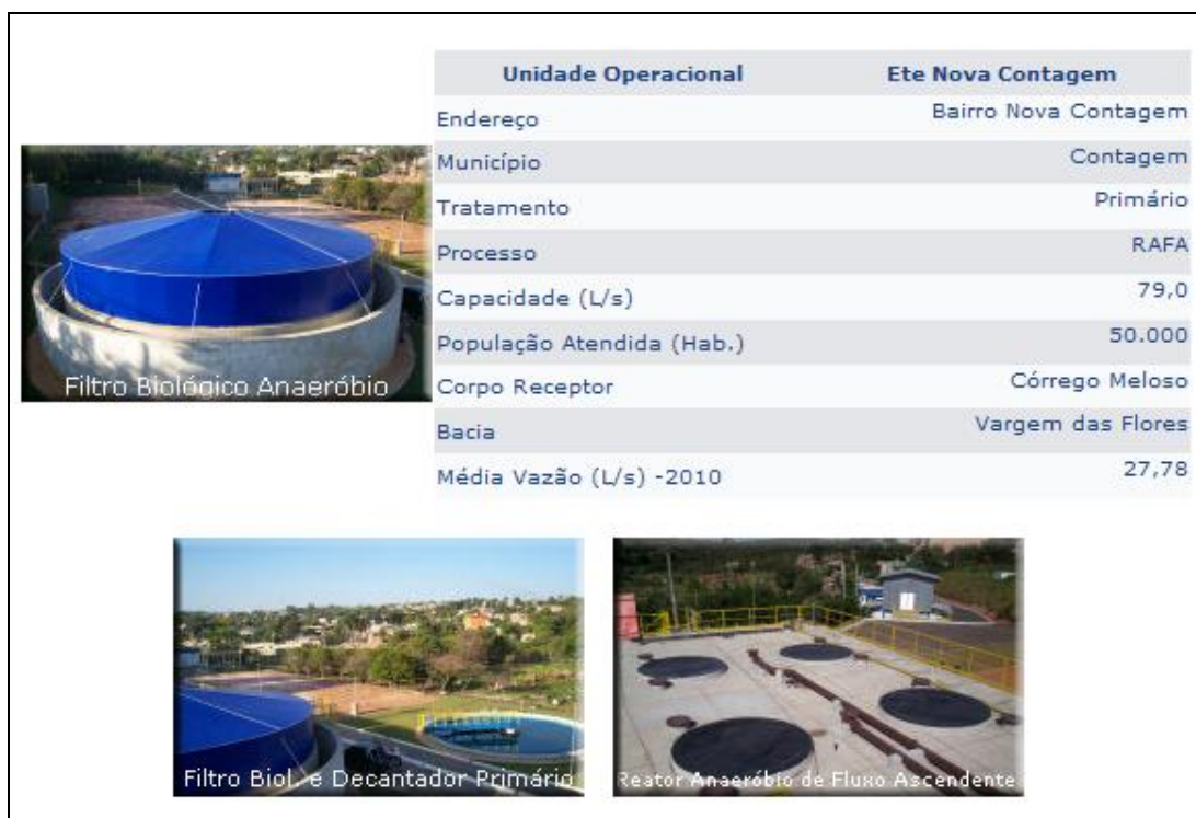
Figura 7 – Estação de tratamento de Esgoto em Contagem
