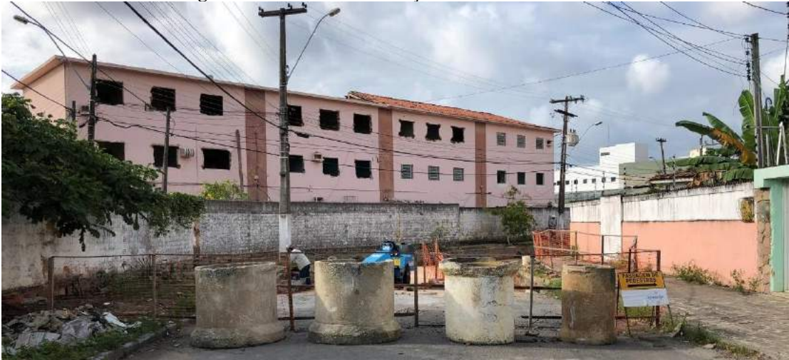
Imagem 10 - Avenidas se debruçam sobre a casa condenada
