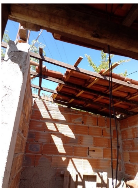
Figura 31 - Construção do novo galinheiro
