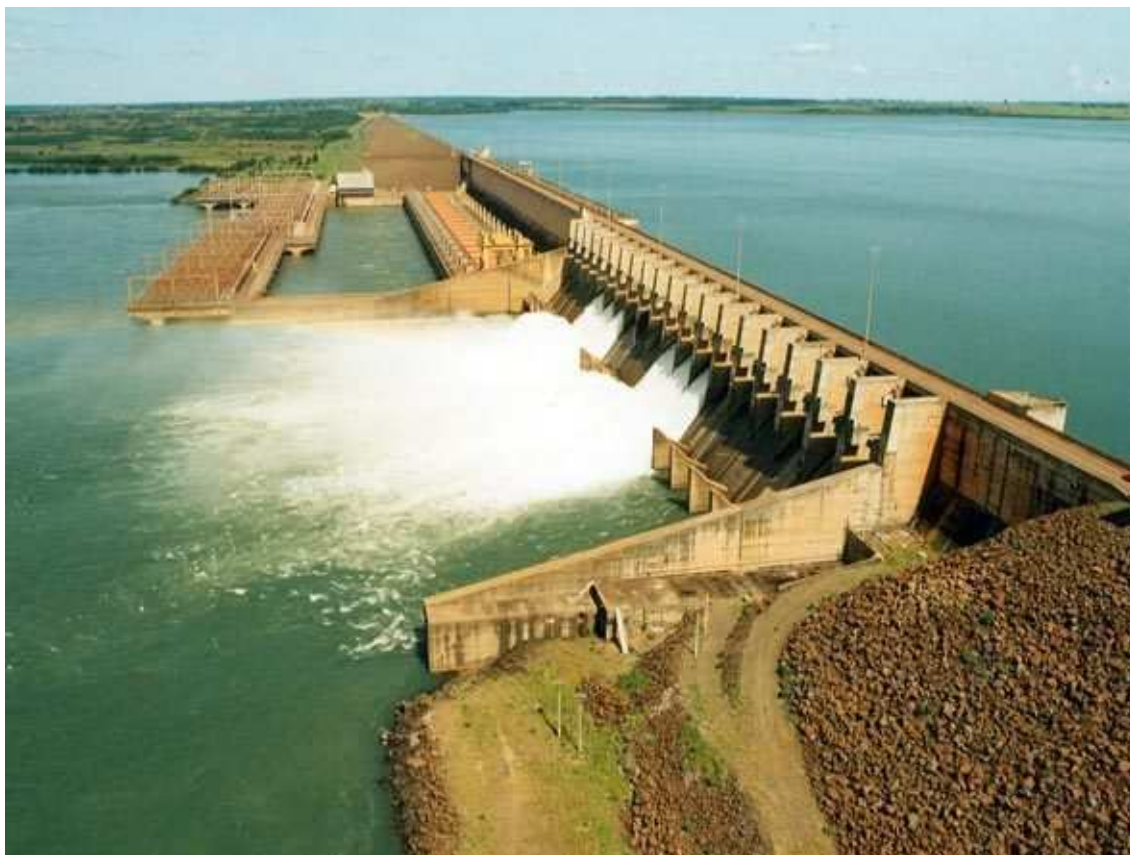
Usina Hidrelétrica de Ilha Solteira – São Paulo
