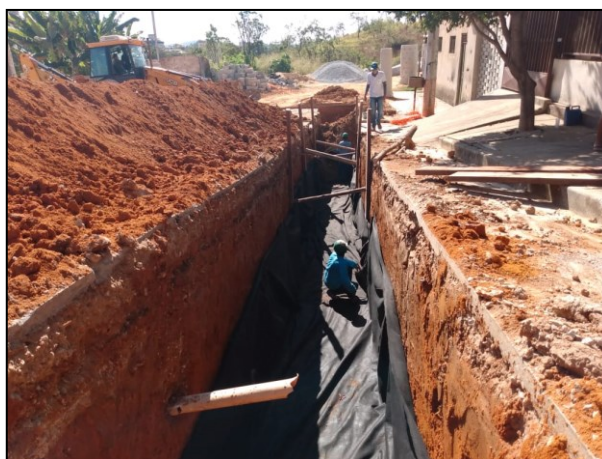
Figura 6.8 Fixação/Grampeamento da manta geotêxtil do Berço no Fundo e Laterais da Vala Fonte: Arquivo Próprio, 2020
