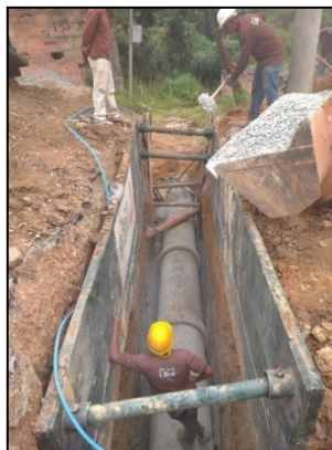
Figura 6.17 Execução do contraberço Envelopado por Manta Geotêxtil Fonte: Arquivo Próprio, 2020
