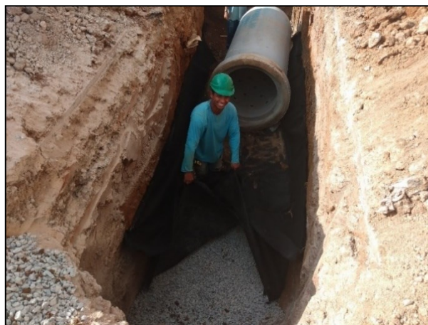
Figura 6.10 Berço de Brita 01 envelopado com manta geotêxtil
