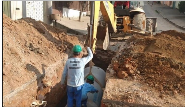
Figura 6.15 Assentamento do tubo Fonte: Arquivo Próprio, 2020
