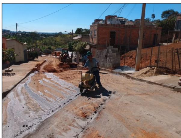
Figura 6.3 Corte pavimento asfáltico Fonte: Arquivo Próprio, 2020
