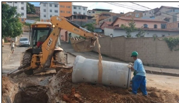
Figura 6.12 Fixação prévia do anel na ponta do tubo Fonte: Arquivo Próprio, 2020
