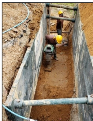
Figura 6.7 Regularização do fundo da vala Fonte: Arquivo Próprio, 2020
