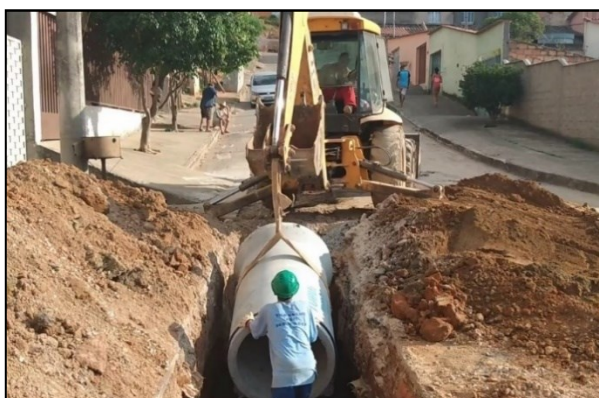
Figura 6.14 Alinhamento em relação ao eixo da vala Fonte: Arquivo Próprio, 2020
