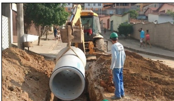
Figura 6.13 Içamento do tubo com filtros direcionados para baixo Fonte: Arquivo Próprio, 2020
