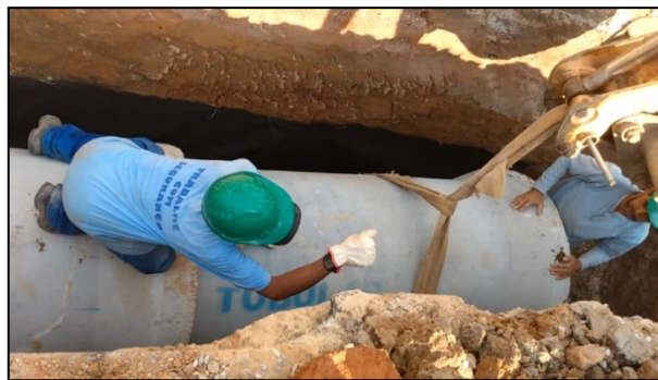
Figura 6.16 Encaixe ponta na bolsa dos tubos Fonte: Arquivo Próprio, 2020
