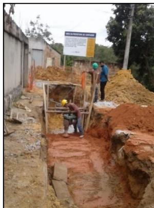
Figura 6.19 Compactação mecanizada da vala
