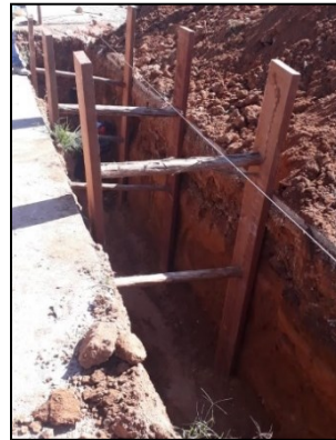
Figura 6.6 Pontaiteamento Fonte: Arquivo Próprio, 2020
