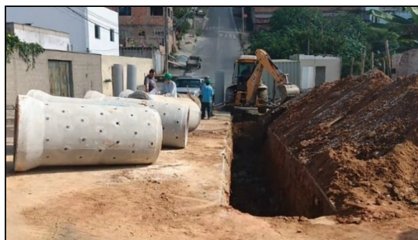
Figura 6.4 Escavação de vala Fonte: Arquivo Próprio, 2020
