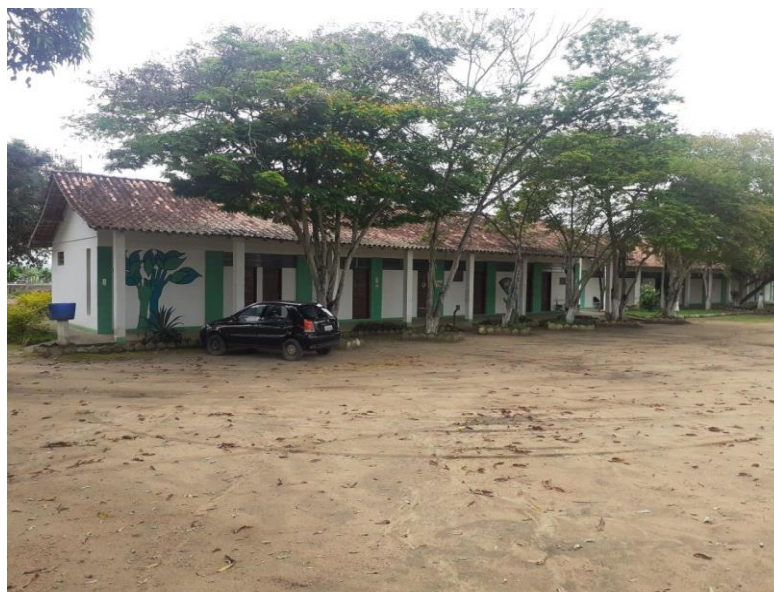
Figura 8 – Vista da EFASA
