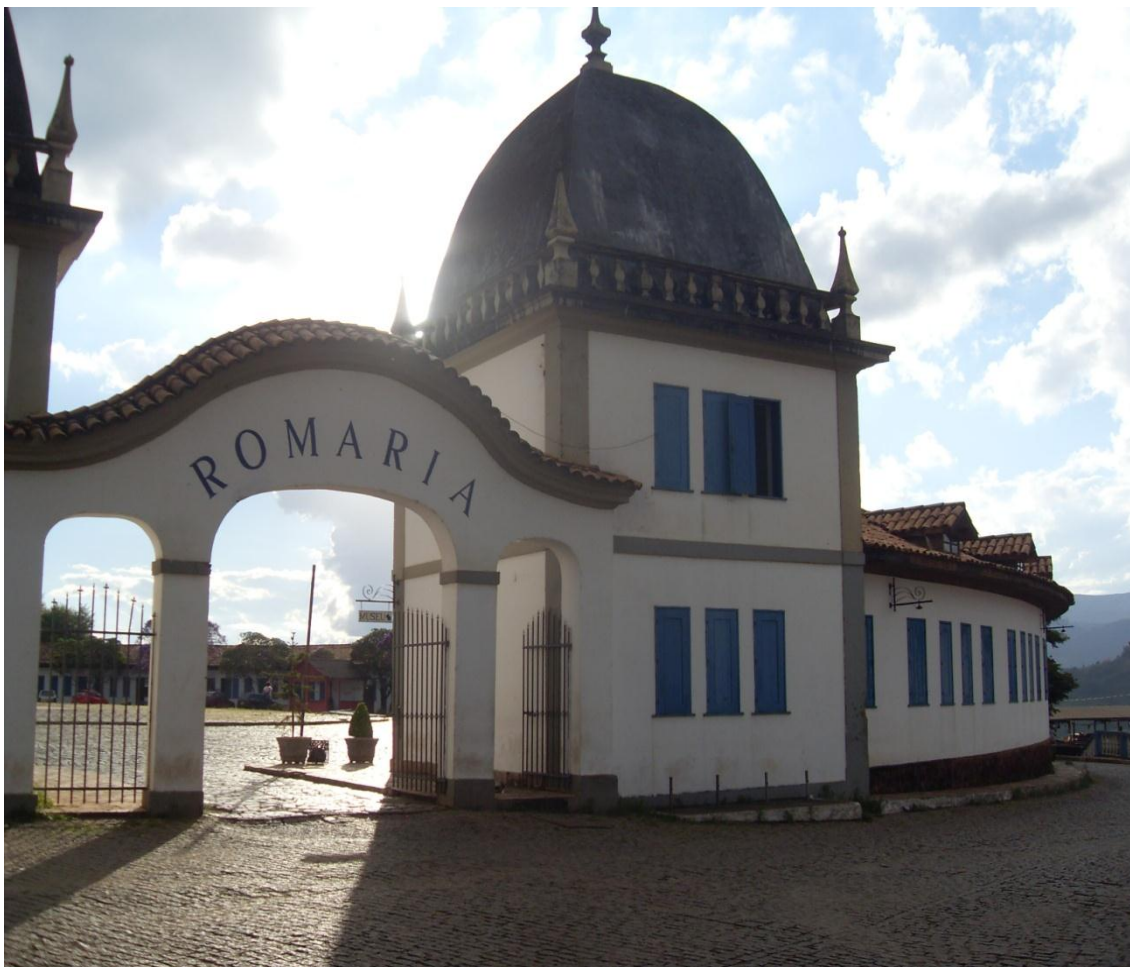
Figura 11: A partir do pórtico de entrada da antiga edificação da Romaria, a mesma foi reconstruída e inaugurada dia 30 de julho de 1995.
