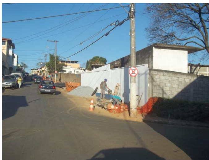
Obras no Cemitério Nossa Senhora da Conceição, parte lateral, Fonte: Flávia Ferreira e Silva Peixoto (julho de 2012)
