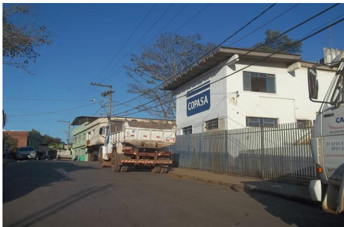
Estação de Tratamento de Água COPASA, situada na Rua Barão de Congonhas. Fonte: Flávia Ferreira e Silva Peixoto (julho de 2012)
