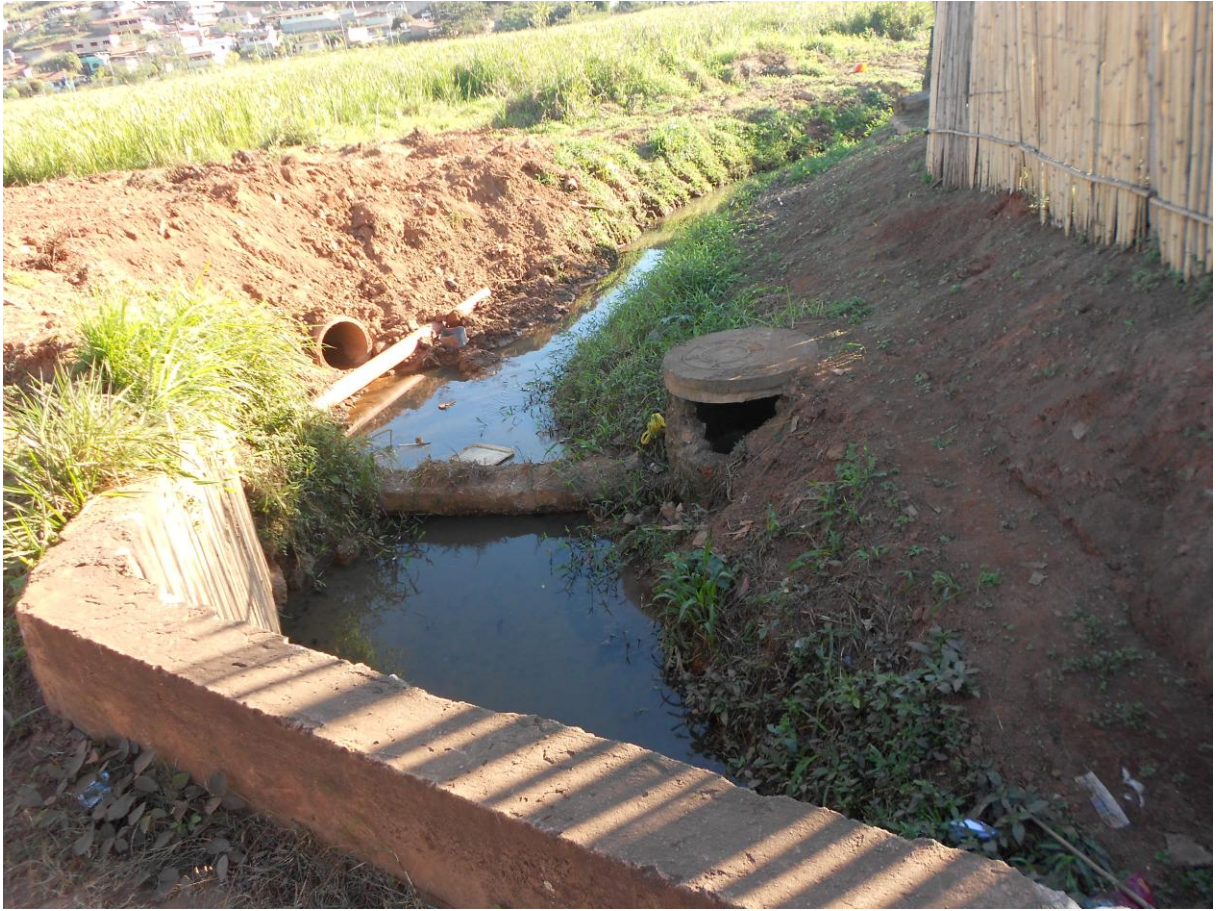
Foto 3: Esgoto que vem das residências e escorre lentamente às margens da BR-383.
