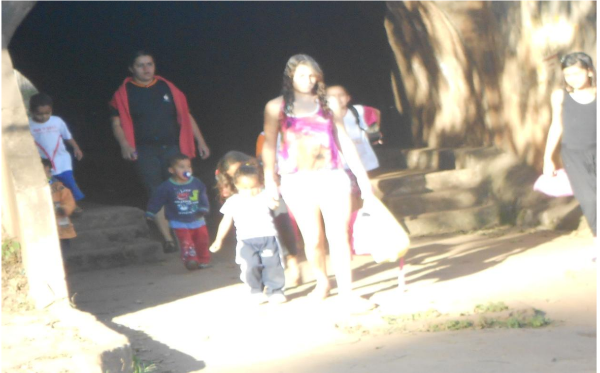
Foto 4: Túnel de travessia abaixo da BR-040 utilizado pela comunidade de Dr. Joaquim Murtinho
