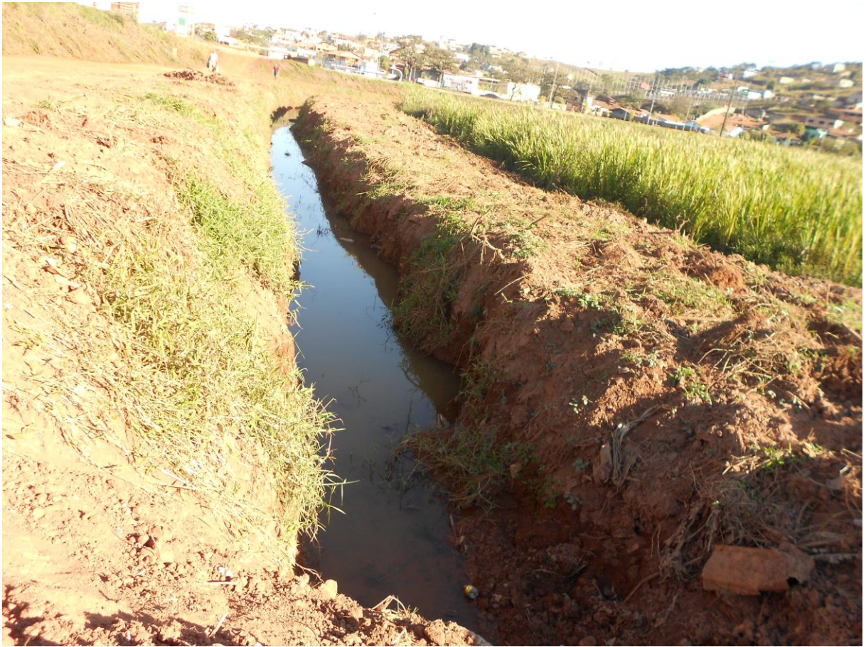
Foto 2 – Esgoto a céu aberto às margens da BR-040
