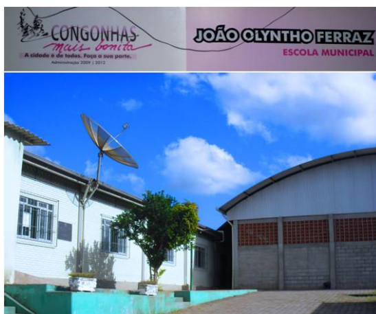
Vista de frente da escola.
