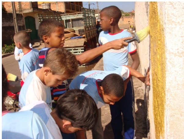
Alunos executando a 1ª demão de tinta no muro.
