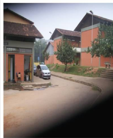
Foto 04 - Vista parcial da escola.
