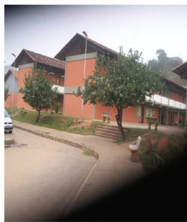
Foto 03 - Vista parcial da escola.
