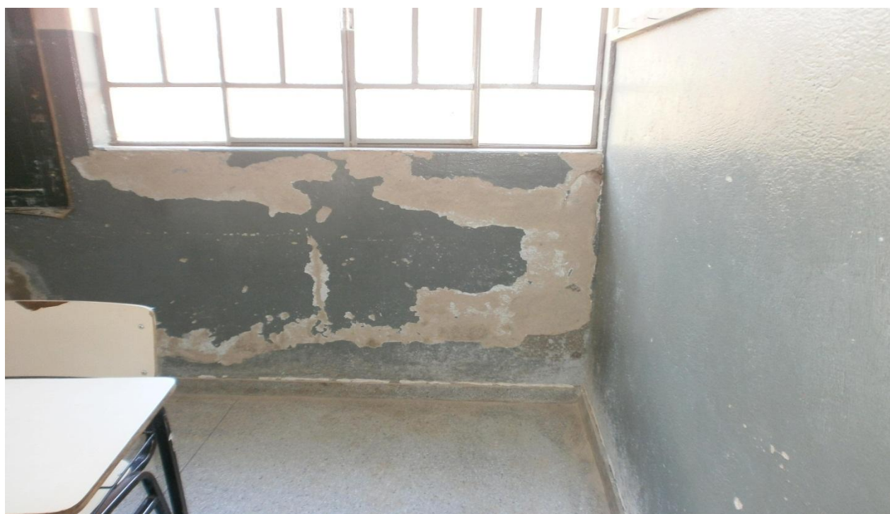
Sala de aula no início de 2012 – Antes da reforma
