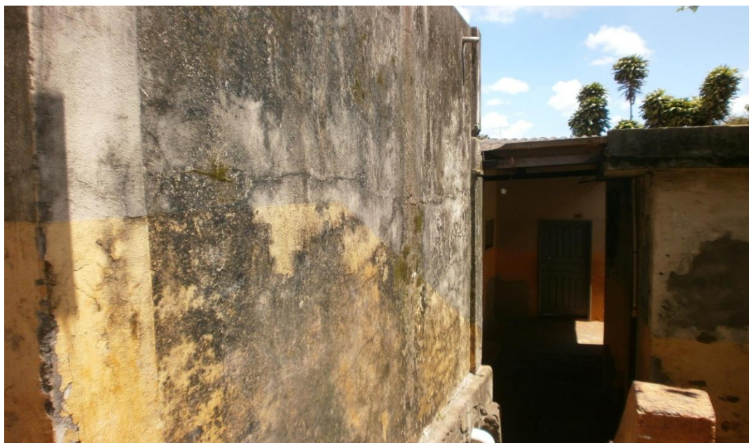
Parede do banheiro no início de 2012 - Antes da reforma
