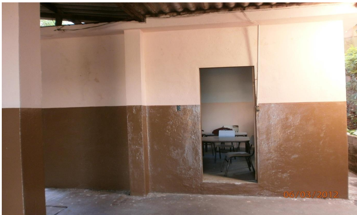
Entrada de sala de aula após reforma
