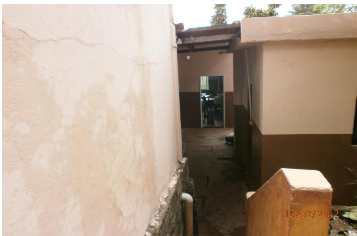
Parede do banheiro após reforma em abril/2012
