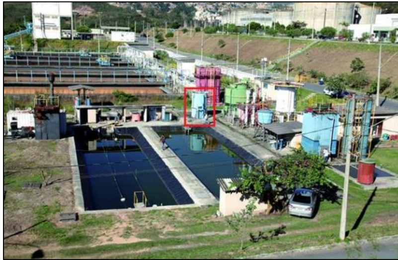
Figura 4.2: Foto do CEPTS (com destaque para o reator UASB utilizado no experimento)
