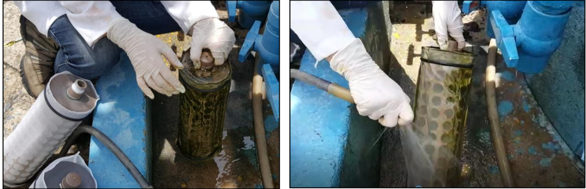
Figura 4.11: Limpeza com água e substituição das malhas
