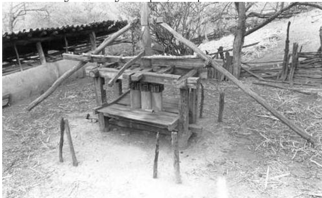
Figura 70 – “Engenho de pau”, Município de Minas Novas
