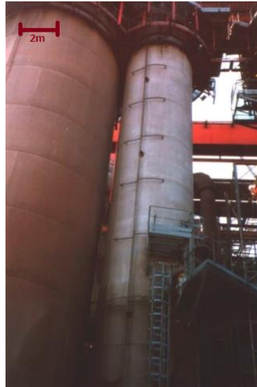
Figura 11 - Foto da carcaça externa da câmara de checkers e câmara de combustão para um regenerador com câmara de combustão externa. Fonte: SCHAUB et alii (2017).
