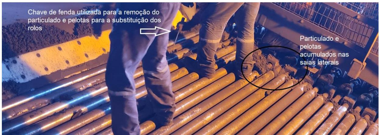
Figura 2. Remoção de particulado e pelotas.
