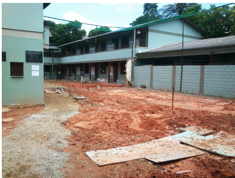
Figura 3 - Reforma da escola Fonte: Fotografia do autor
