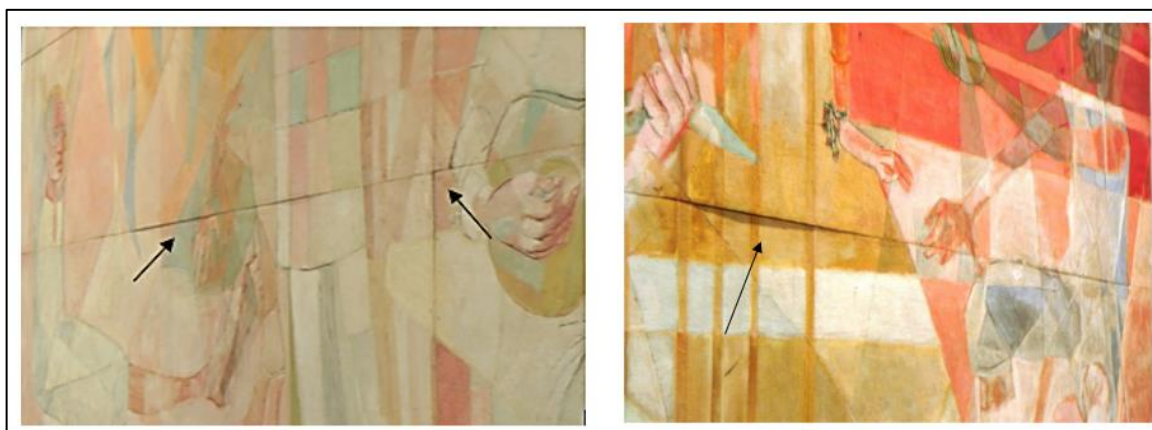
Figura 148- Painel Frevo: Abaulamento/movimentações das bordas
