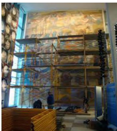
Figura 90 - Desmontagem dos painéis na ONU em novembro de 2010
