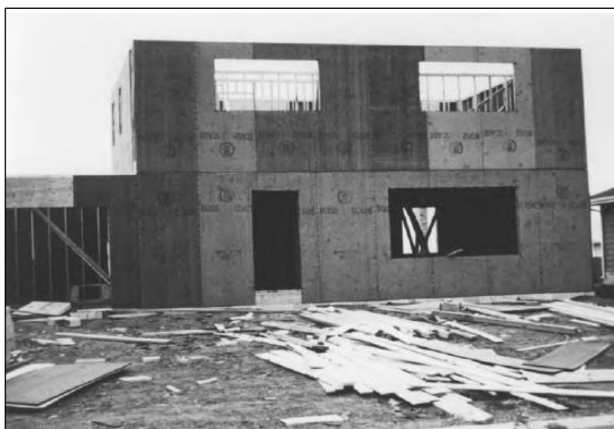
Figura 28 - Placas de chapa duras aplicadas externamente antes do revestimento
