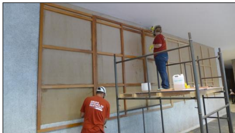
Figura 96 - Preparação da nova estrutura (tipo chassi) para receber o painel
