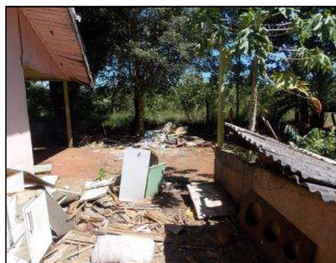
O local ainda repleto de resíduos sólidos trazidos pela enchente de 2014.
