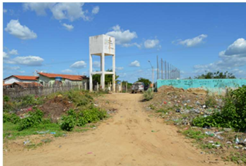
O reservatório elevado abastece as casas com a água de um poço profundo, mas a quantidade de água é insuficiente para atender a demanda.
