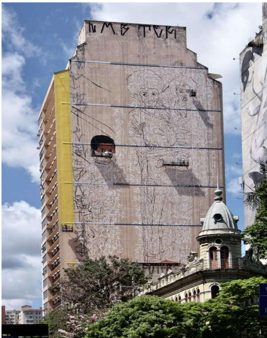
Figura 17 - Edifício Itamaraty antes da intervenção do CURA ficar pronta
