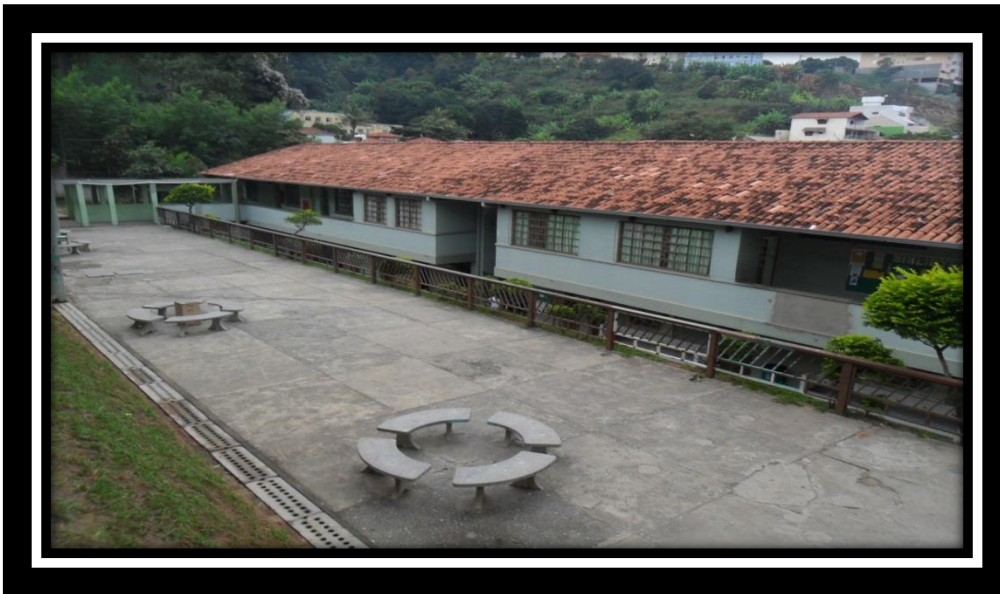
FIGURA 2: Vista do pátio da EMSF
