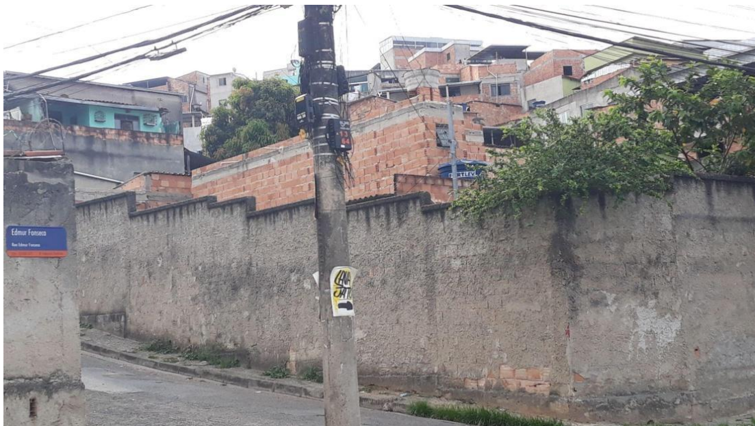
Figura 21 - Moradia sem pilar
