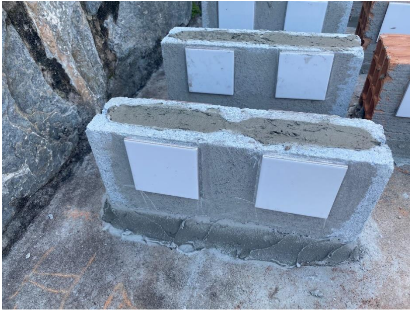
Figura 23 - Corpo de prova executado
