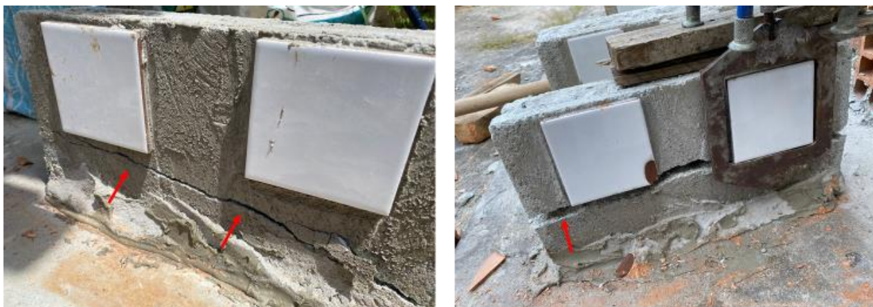
Figura 42 – Trincas que surgiram na ruptura do bloco
