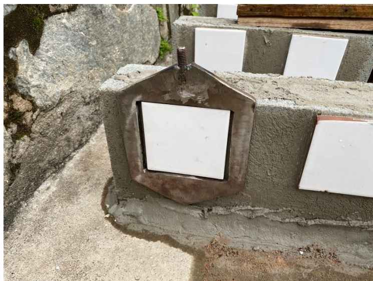
Figura 21- Disposição da peça metálica no corpo de prova
